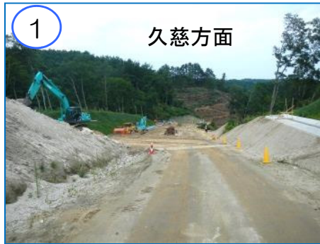
滝ノ沢地区の山を切り取り、一の渡地区に運搬し、盛り土工事を進めています。
