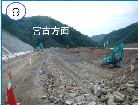
国道45号沿い急斜面の山の切り取り工事を進めています。発破作業による国道の一時通行止め(5分間程度)にご協力願います。
