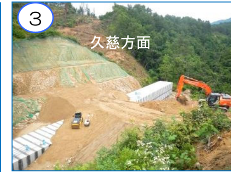
深い沢部に設置済みのコンクリート製函渠部分の盛り土工事を進めています。
