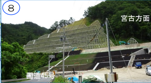
国道45号に面した盛土部の仕上げ作業を進めています。
