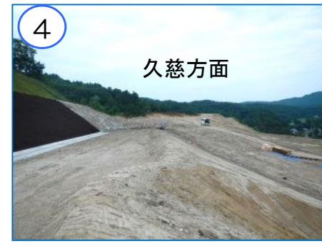
巢合地区の硬い岩盤切り取り箇所法面仕上げ(植生基材吹付け:茶色部分)の状況です。
