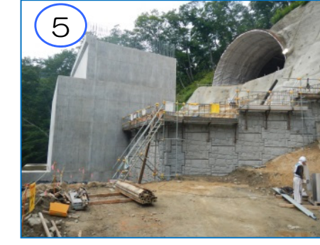
(仮称)新柳瀨橋A2橋台と柏木平第1トンネル間の、補強土壁を造っています。
