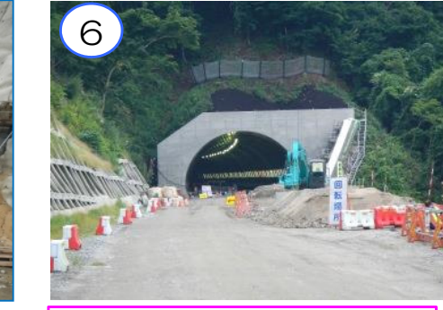
(仮称)柏木平第1トンネル久慈側坑口部の仕上げを進めています。
