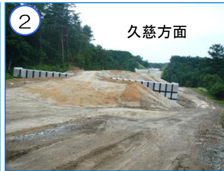
滝ノ沢地区の山を切り取り、一の渡地区に運搬し、盛り土工事を進めています。
