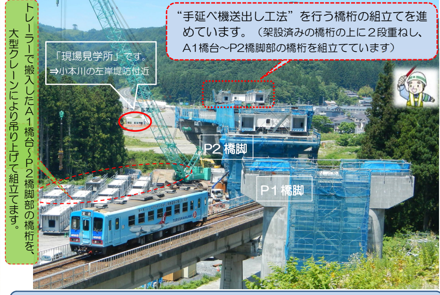
三陸鉄道を跨ぐ部分等(A1橋台～P2橋脚間)の架設準備作業状況です
