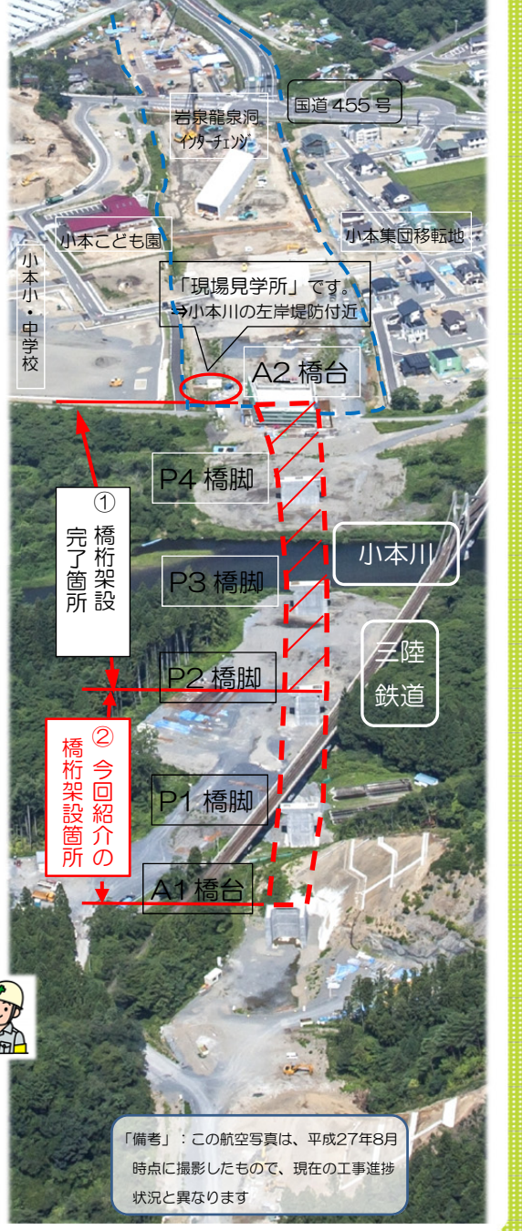
空から見た岩泉龍泉洞IC付近～新小本大橋間の工事状況です。
