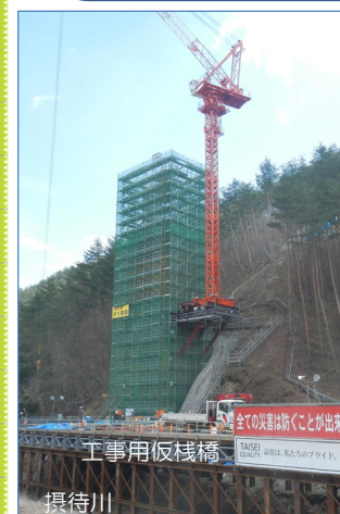
P1 橋脚 橋脚工事は約半分の高さまで立ち上がりました。
