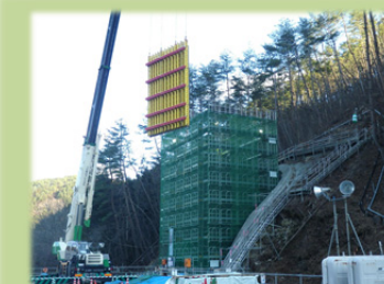
大型システム型枠を大型クレーンで吊り込み状況
