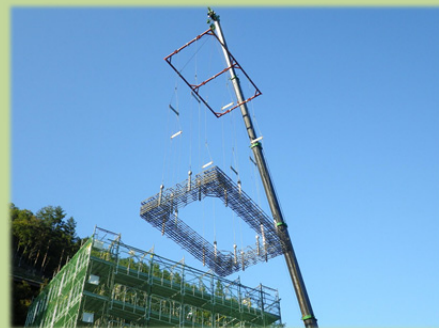
鉄筋枠組み部材をクレーンで吊り込み状況。
