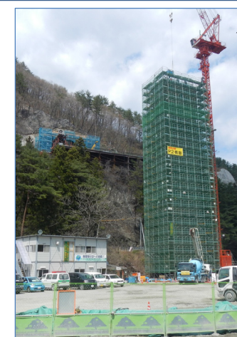
P2 橋脚 橋脚工事は最上段部分を施工中です。
