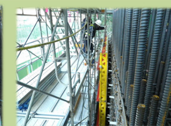
大型システム型枠(黄色)のセット状況
