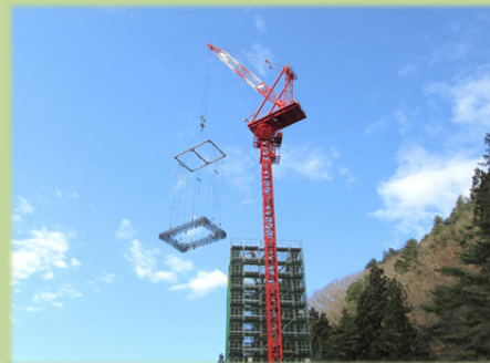
鉄筋枠組み部材をクレーンで吊り込み状況。
