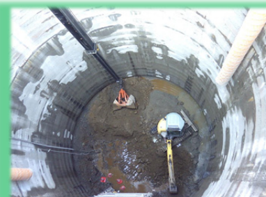
大口径深礎杭の掘削状況
