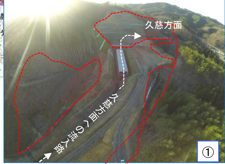
菅窪地区 田野畑インター(仮称)部の切土区間の状況(上空から撮影) ・久慈方面への流入路を先行して函渠設置工事・切土工事を進めました。
