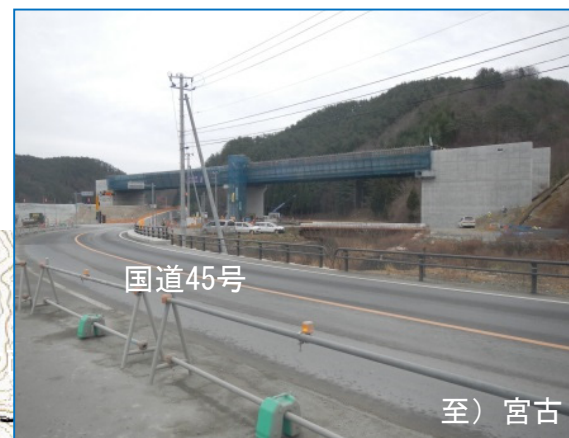
④ 新小本大橋上部工工事施工:(株)東京鐵骨橋梁
