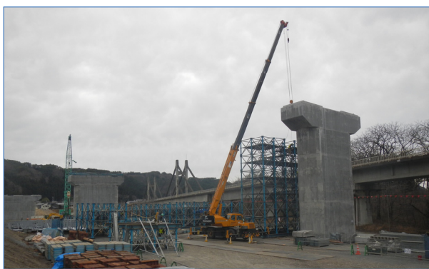
新小本大橋の現場です。橋桁を架けるための準備作業を進めています。
