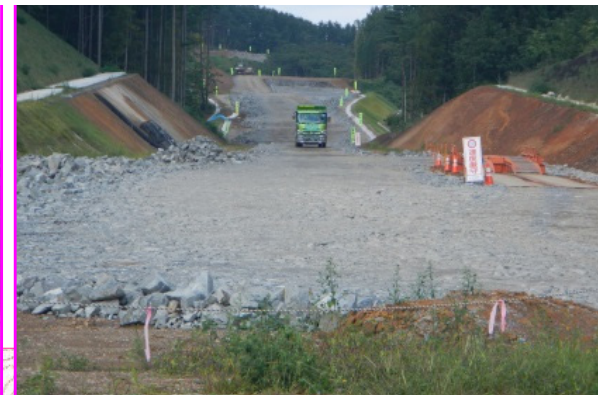
① 菅窪東地区道路改良工事 施工: 樋下建設(株)
