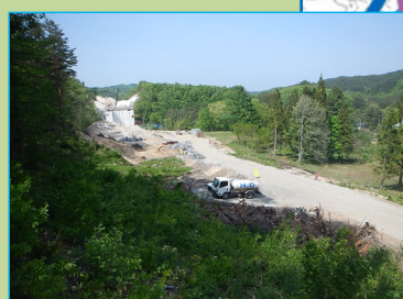
尾肝要工区の盛土等工事箇所の状況。
