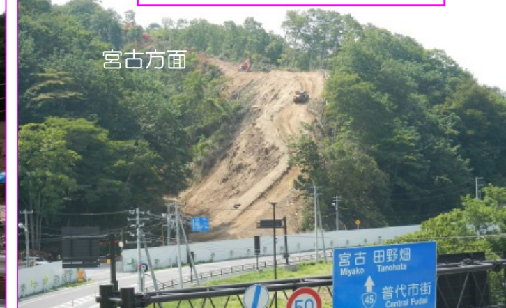
④普代南地区改良工事 施工:青木あすなろ建設(株)
