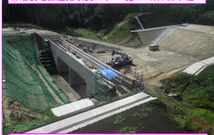
③沼袋地区道路改良工事 施工:(株)森本組
