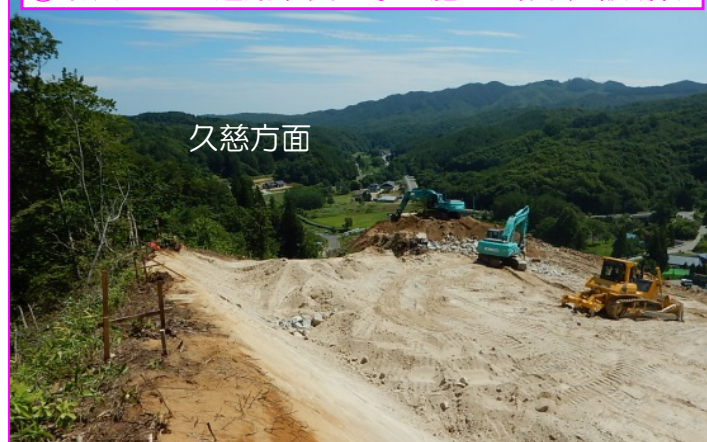
⑥沼袋北地区道路改良工事 施工:昭栄建設(株)
