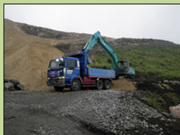
一ノ渡工区の切土工・土砂運搬状況。
