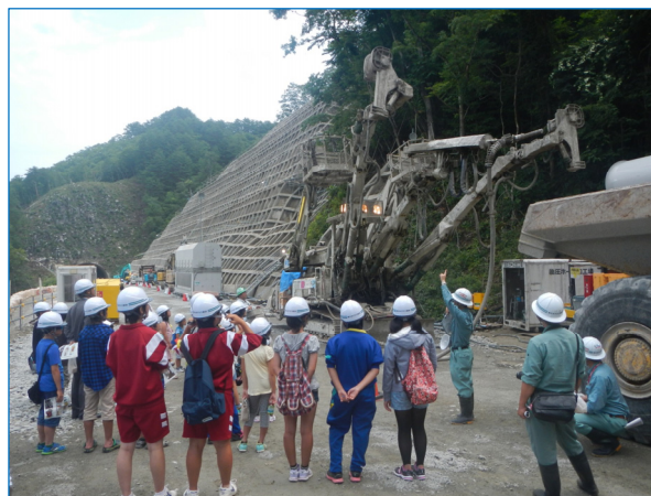
作業用の複数の腕(アーム)を付けたトンネル車両のスムーズな動きに興味を持って見学していました。
