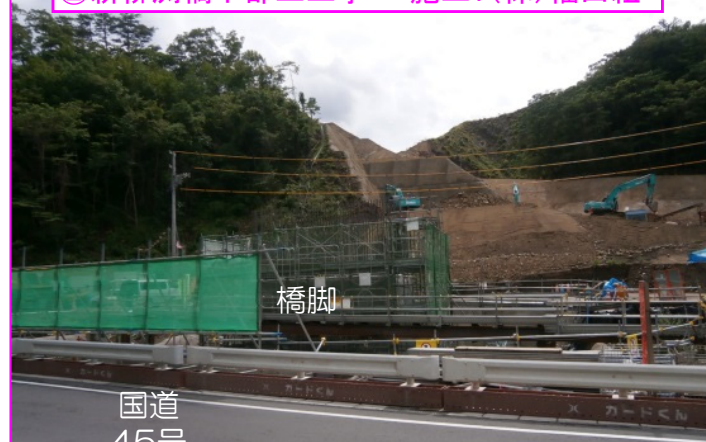
②新柳瀨橋下部工工事 施工:(株)福田組
