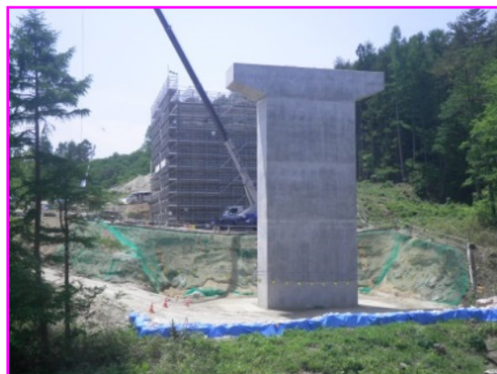
②新一の渡橋下部工工事 施工:(株)森本組
