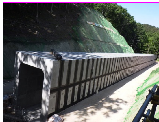
④滝ノ沢南地区道路改良工事 施工:昭栄建設(株)
