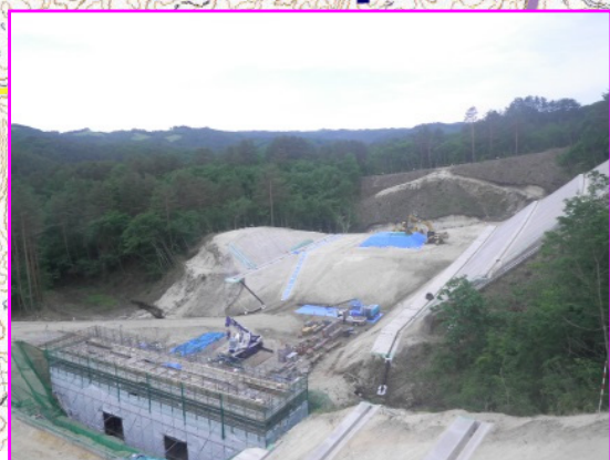
⑤沼袋地区道路改良工事 施工:(株)森本組
