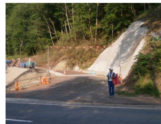
③新柳瀨橋下部工工事 施工:(株)福田組
