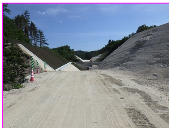
⑧沼袋北地区道路改良工事 施工:昭栄建設(株)
