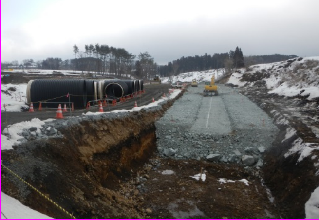
①大芦南地区道路改良工事 施工:(株)森本組
