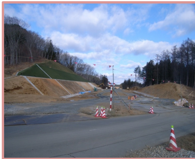
山側の部分を切り取りしている状況です。
