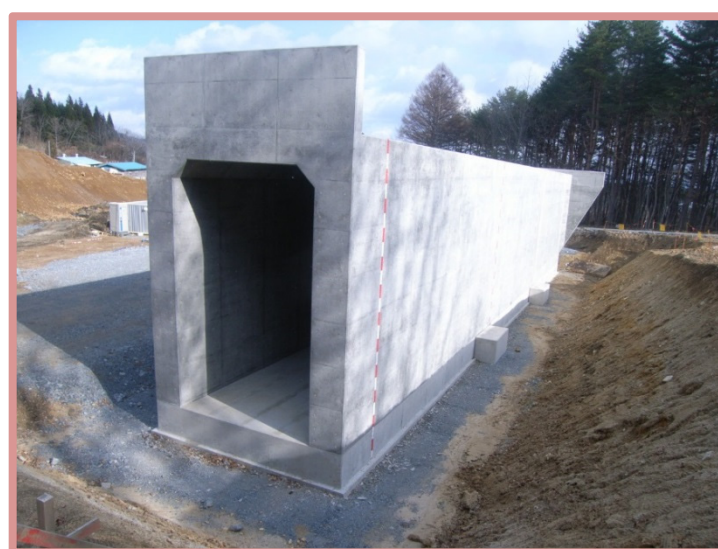
沢部の函渠(トナリ)が完成した状況です。
