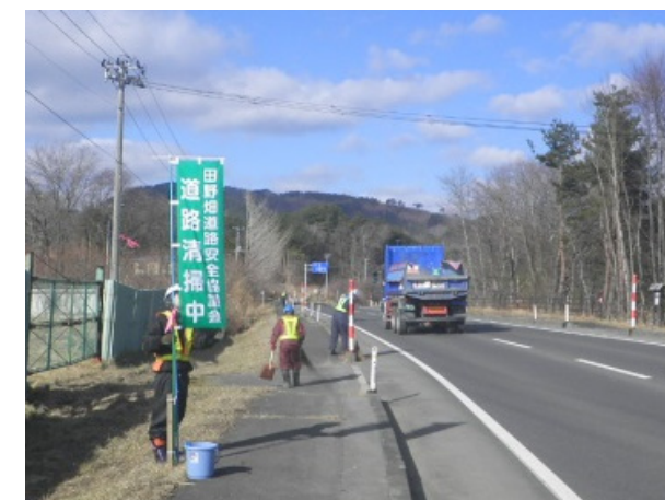
反射標やスノーボールの汚れを落とし、路肩に溜まった土砂を除去しました
