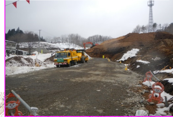
④菅窪地区道路改良工事 施工:樋下建設(株)
