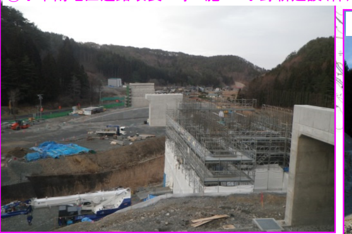
③ 小本南地区道路改良工事 施工:小野新建設(株)
