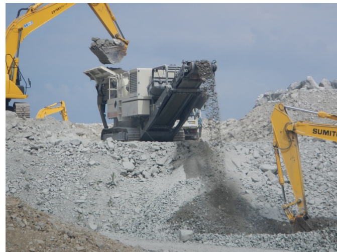
砕石機による二次破碎
