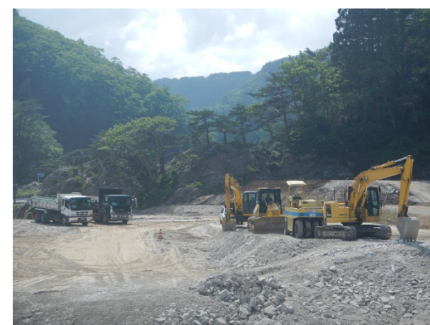
島越駅前広場の地盤かさ上げ工事状況
