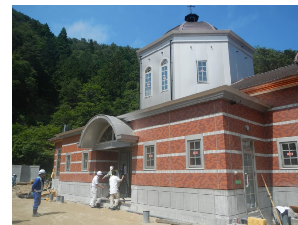
復旧工事中の島越駅も公開されました
