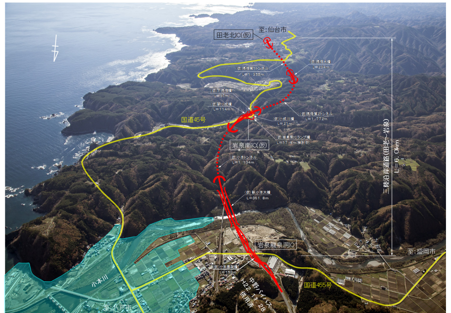
田老岩泉道路全景(平成25年11月撮影)
