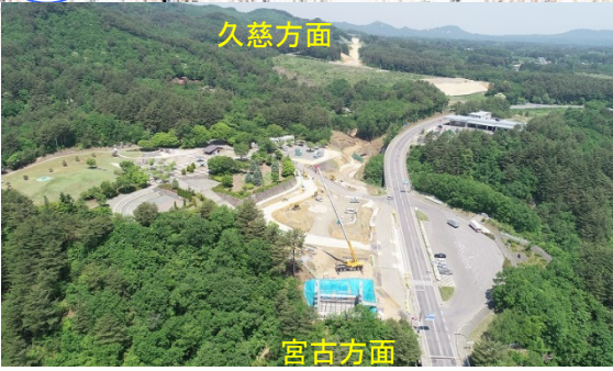
切廻し道路の工事中です。
