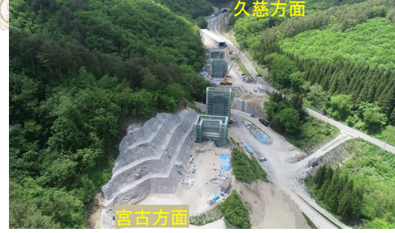
橋台と橋脚の工事中です。
