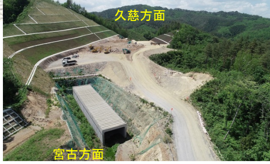
切土の工事中です。
