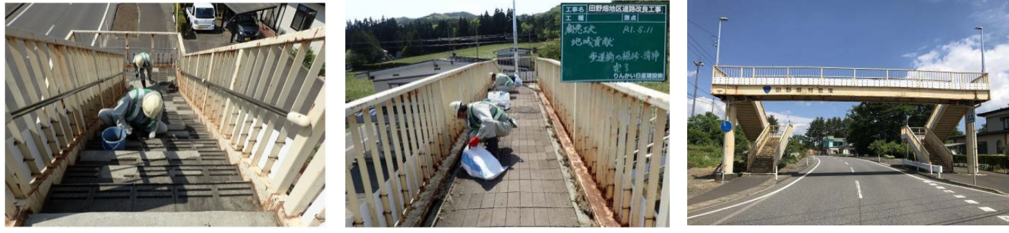
〔田野畑村菅窪歩道橋の整備〕
