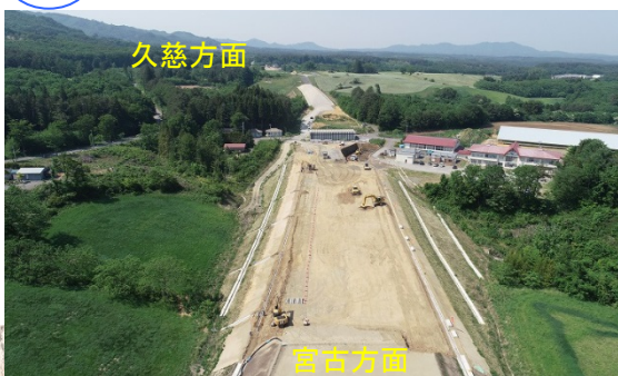
盛土と排水の工事中です。
