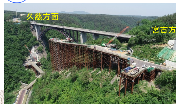
橋台と橋脚の工事中です。
