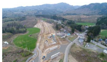
〔4月〕工事着手前
