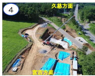
函型通路の底部を作業中です。
