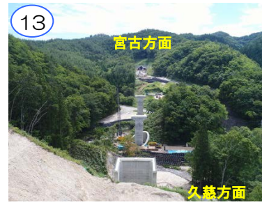
工場、橋桁の製作中です。
