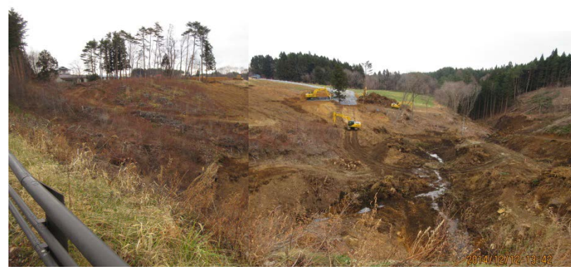
工事に着手, 運搬路の整備です。(H26. 12)
