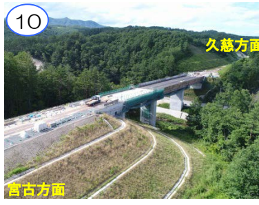
橋の床と壁の鉄筋作業中です。
