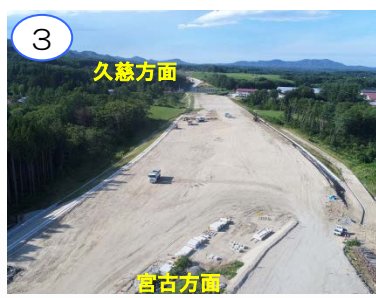
(大芦工区) 排水構造物と盛土の作業中です。
