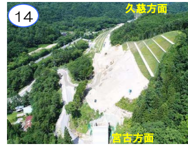
発破して、岩山を掘削中です。
