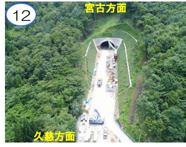
普代側から、トンネルの掘削中です。
