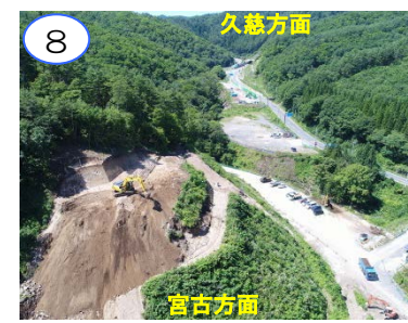
工事用道路の作業中です。
