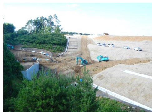
工事終盤です。(H30. 7)
