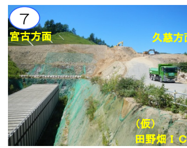
(菅窪工区) 地山を掘削して運搬中です。
