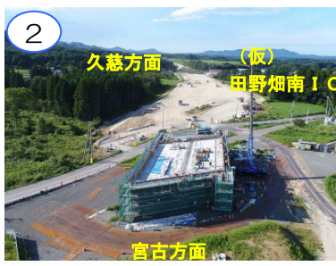
橋台と壁の型枠作業中です。
