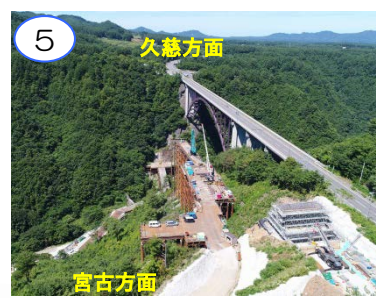
橋台と仮栈橋の作業中です。
