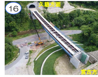
足場と型枠の作業中です。
