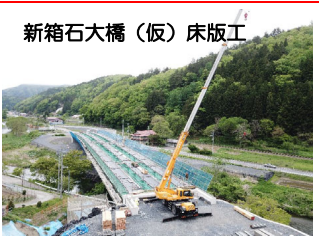
⑰施工：(株)森組
