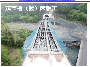
⑰施工：(株)森組
