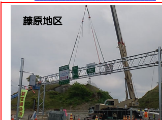
②施工：岩手標識(株)
