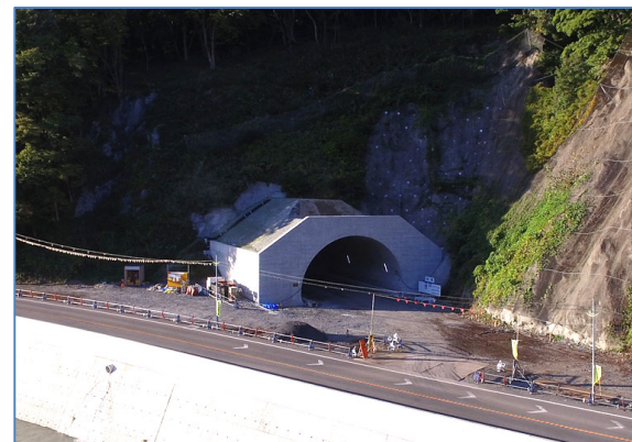
下川井トンネル(仮) 宮古側
