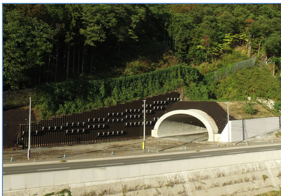
下川井トンネル(仮) 盛岡側
