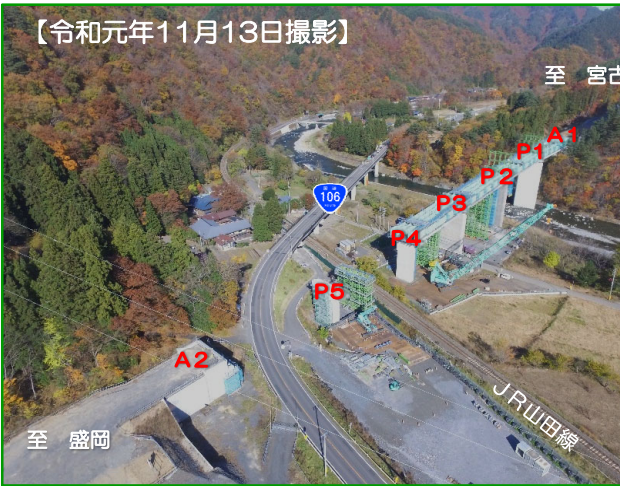
この時点で橋桁が架かっていたのはA1橋台からP4橋脚まででした。
