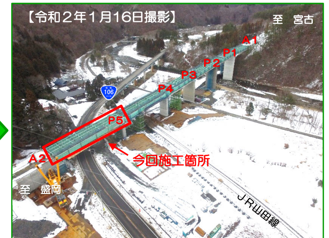
今回の作業で、A1橋台からA2橋台まで橋桁が架かり橋が繋がりました。
