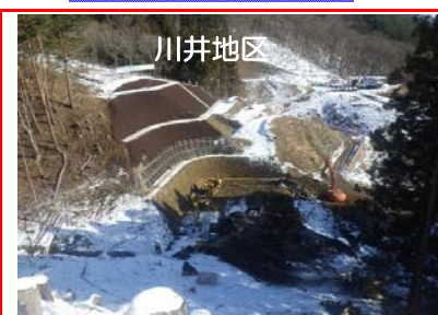
⑧施工：大豊建設
