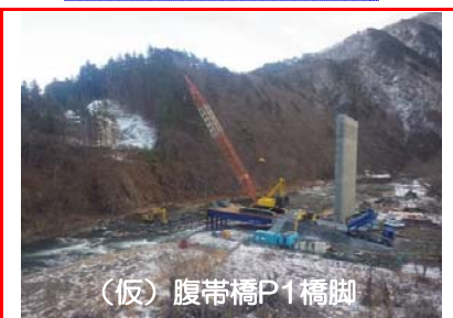
⑨施工：大豊建設
