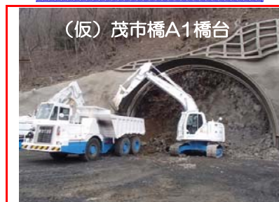
⑥施工：前田建設工業
