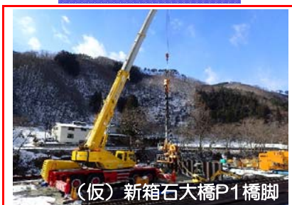
④施工：安藤・間
