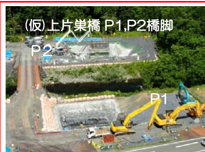
(仮)上片巣橋P1橋脚は法面吹付け、P2橋脚はコンクリートにより埋戻しをしています。
