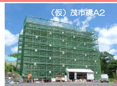
(仮)茂市橋の橋台の型枠を組立てています。
