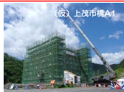
(仮)上茂市橋の橋台の壁の型枠を解体しています。
