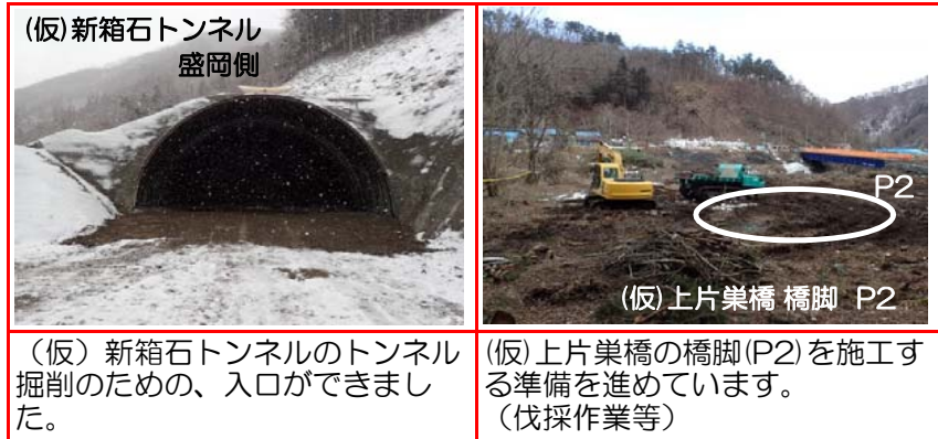
⑥施工：安藤・間
