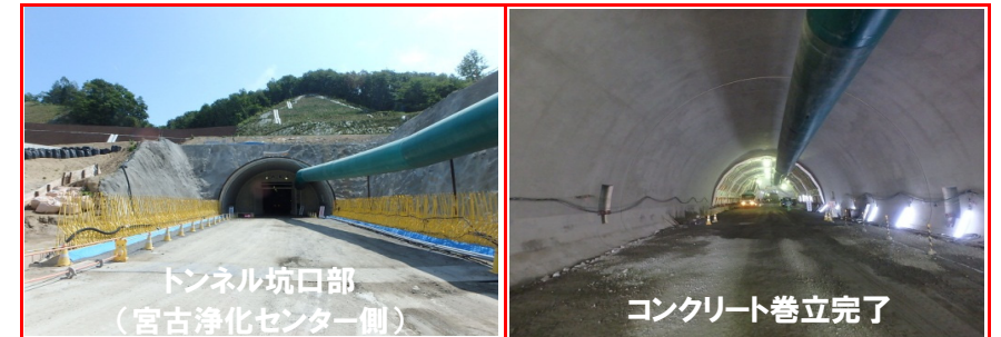
②施工：前田建設工業
