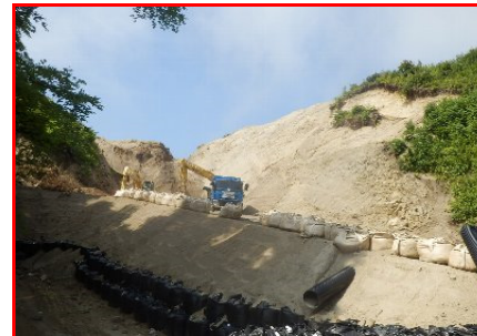
③施工：刈屋建設
