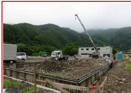
⑧施工：戸田・岩田地崎JV
