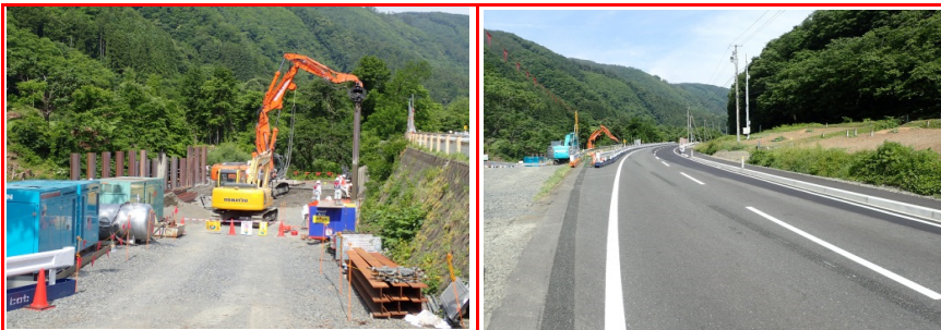
⑦施工：安藤・間
