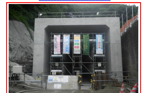
①施工：森本組
