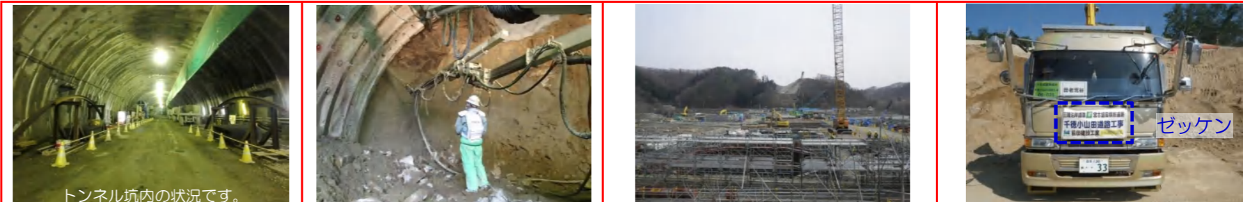
トンネル坑内の状況です。
