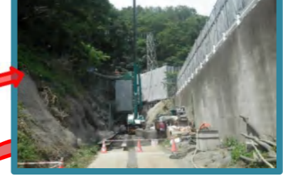
トンネル防護用土留め設置作業
