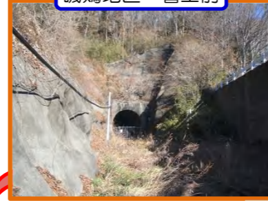
磯鷲地区：着工前
