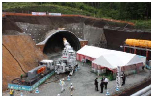
▲トンネル北側坑口
