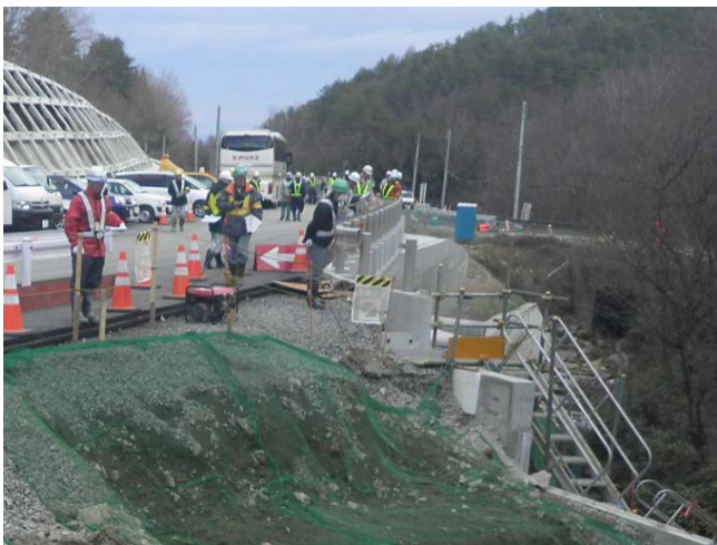
▲現場で改善すべき点などを点検
