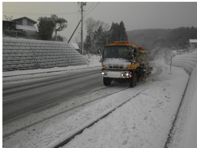
車道除雪及び凍結抑制剤散布状況
