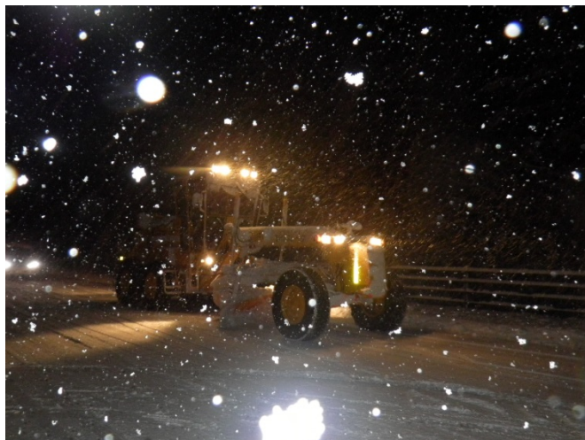
車道除雪状況
