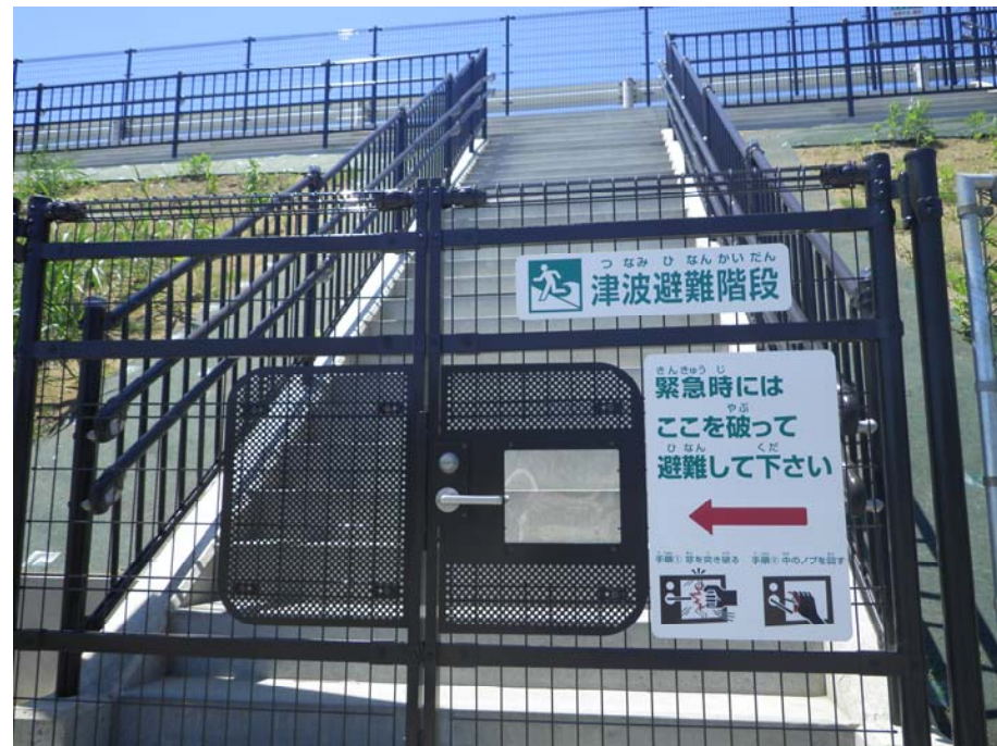
【写真】津波避難階段 進入扉
