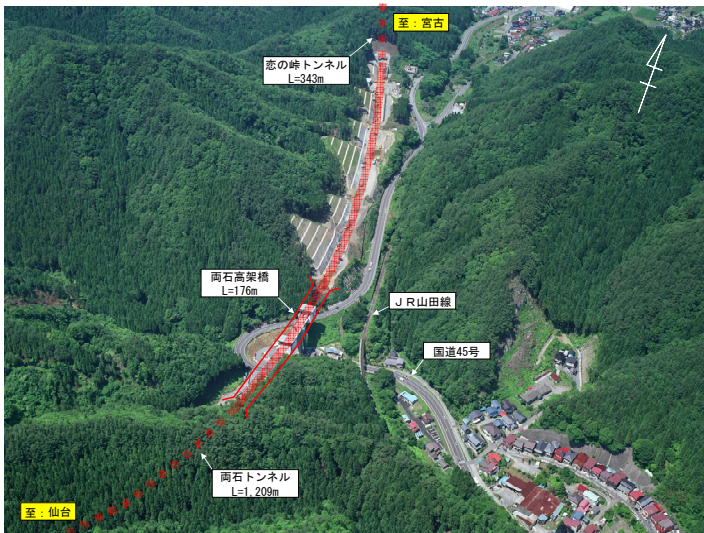
▲整備が進む釜石山田道路(釜石市両石地区)
