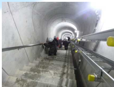
無線局舎から監査廊へ・・・ 98段の長い階段をゆっくりと下りました。
