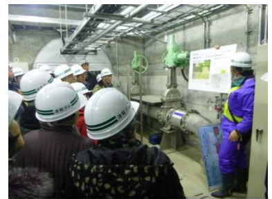
コンジットゲート操作室では、津軽白神湖で起こる濁水について、職員の説明に熱心に耳を傾けていました。
