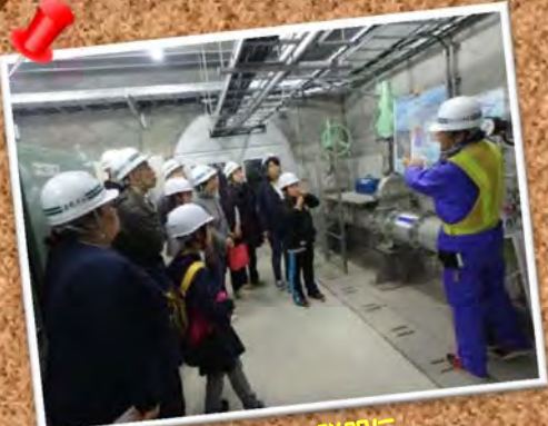
▲ダム内部での説明に皆真剣に耳を傾けています▲
