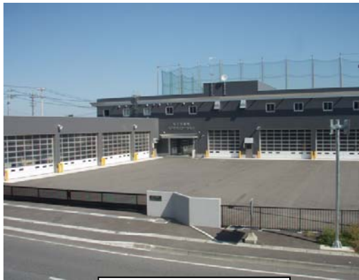
八戸防災ステーション全景
