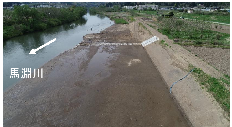
【河道掘削完成状況】
