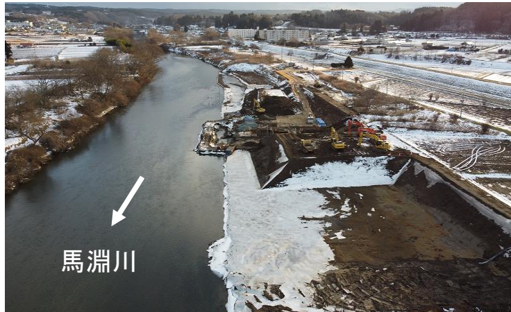
【河道掘削施工状況】
