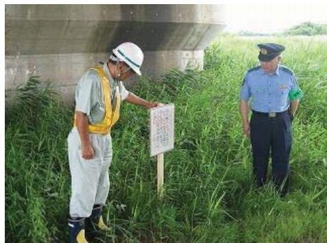
▲設置完了を確認
