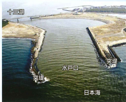
▲突堤完成後の水戸口
