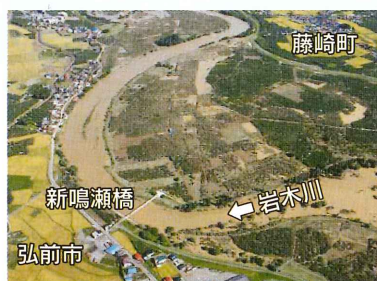
▲平成25年9月台風18号洪水 出水状況
