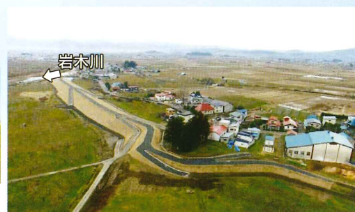
▲堤防整備後(平成29年3月)
