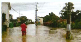
▲主要地方道弘前柏線の 冠水状況 (弘前市大川地先)
