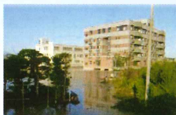
▲介護老人保健施設の 浸水状況 (弘前市大川地先)
