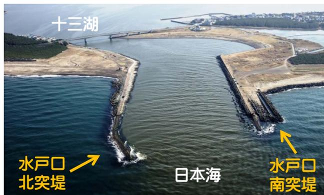
十三湖水戸口突堤（写真左）は、大正15年に着工、昭和21年に完成し、それまで閉塞とそれに伴う湛水被害を繰り返して発生させてきた水戸口の歴史に幕を下ろし、その効果により現在まで水戸口が閉塞することなく維持されていることや、十三湖の漁業や津軽平野の農業振興にも寄与してきたことから、「地域を苦しめた度重なる水戸口閉塞による湛水被害を解消し、岩木川の治水と津軽平野の発展の礎となった貴重な土木遺産」として評価・認定されたものです。
