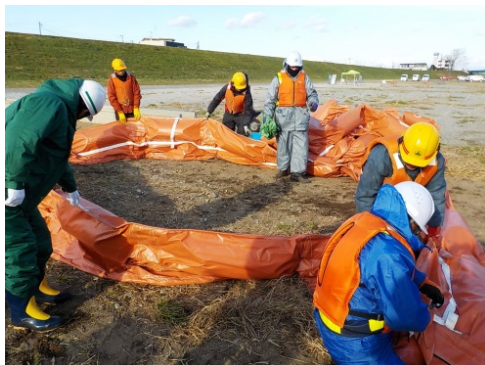
▲ オイルフェンス組立訓練▲
