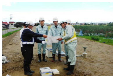
▲ 岩木川中流部堤防改築工事の現場見学の様子 ▲
