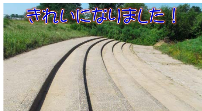
▲除草・泥上げ作業後の様子▲
