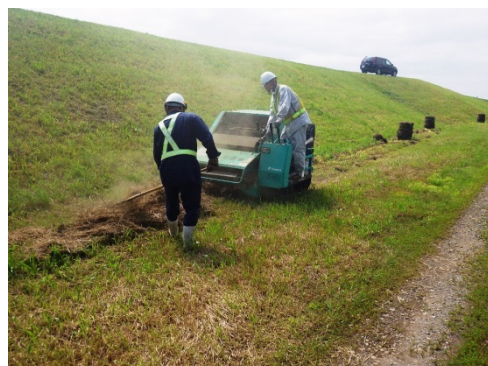
▲堤防除草で発生した刈草をロール状にまとめ、希望者に提供しています
