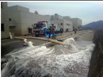
宮城県気仙沼市終末処理場での作業状況
