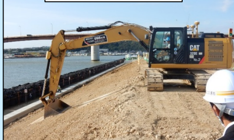
3DMCバックホウを用いた法面整形
