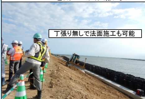
3DMCブルを用いた法面敷均し
