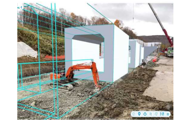
掘削作業時にARと比較
