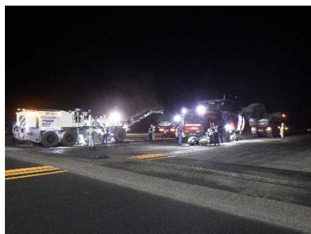
3DMC路面切削機による施工
