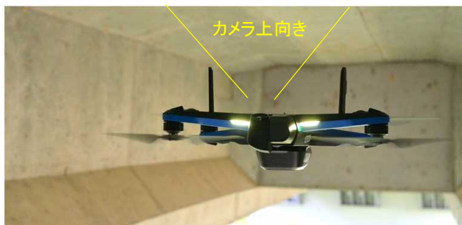
ドローンによる桁間の点検
