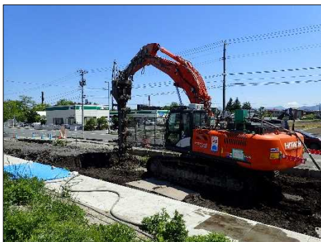
▲パワーブレンダー工法（ICT施工）施工状況写真▲
