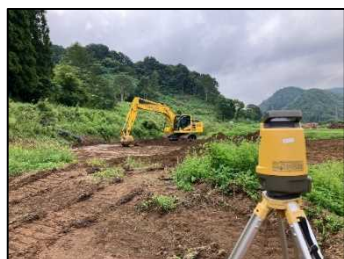
④3次元マシンガイドバックホウによる掘削
