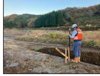
⑥3次元計測機器を使用した 出来型管理(ワンマン測量)
