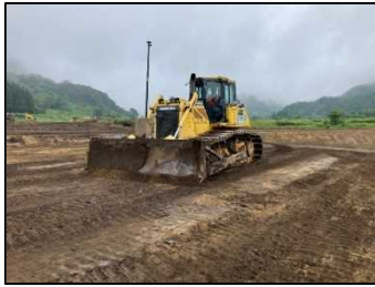
⑤3次元マシンコントロールブルドーザーによる掘削
