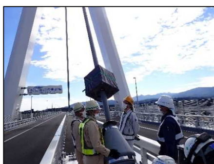
斜材点検ロボットによる点検前の 検証試験状況
