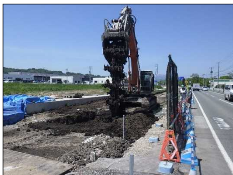
▲パワーブレンダー工法（ICT施工）施工状況写真▲
