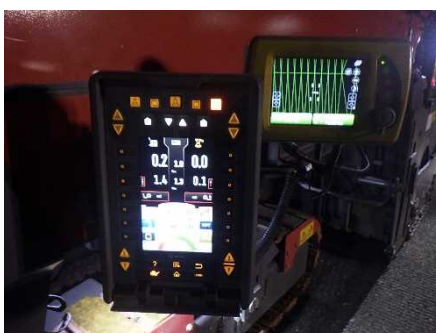
3DMC路面切削機のモニター表示
