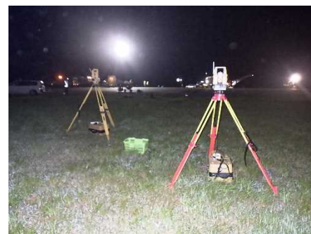
TS等光波方式を用いた3次元出来形管理
