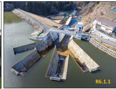
試験湛水状況
