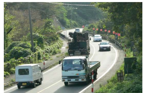
▲小繫地区の線形不良箇所
