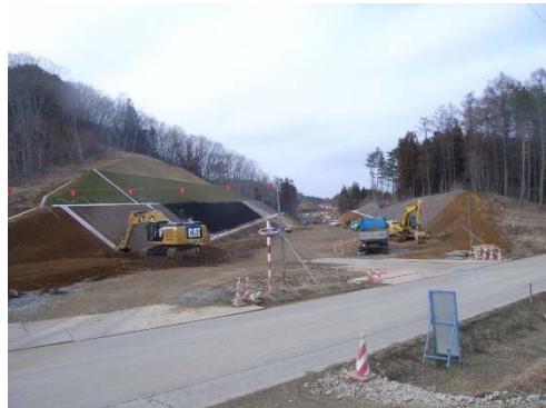
▲三陸沿岸道路(田野畑南～尾肝要)の整備状況
