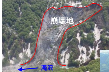
崩壊地の状況
