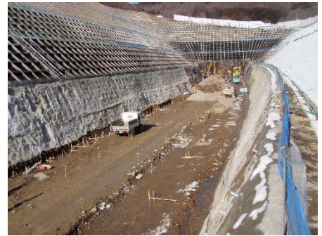
▲都南川目道路の整備状況
