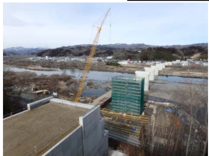
▲三陸沿岸道路(宮古中央～田老)の整備状況
