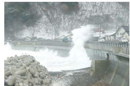
▲国道7号の越波状況
