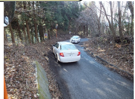
▲幅員狭小状況
