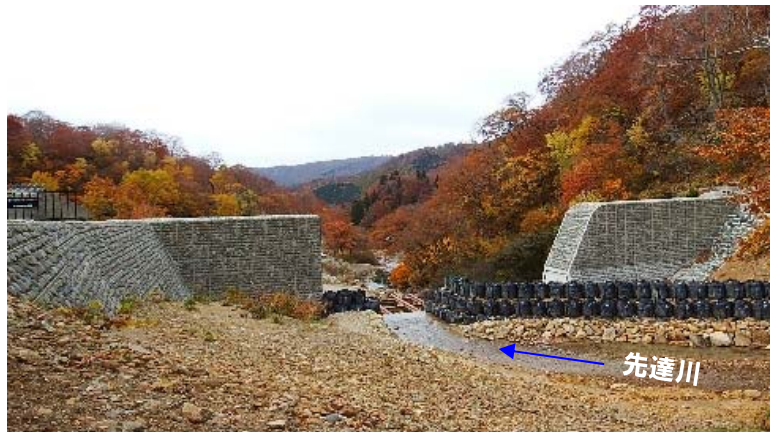
施工状況(H28)
