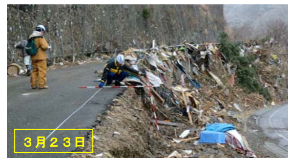
道路の被災状況調査（ガードレール・路肩）
