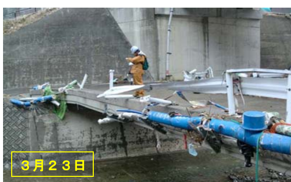
道路の被災状況調査（橋梁）
