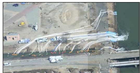
ポンプ車(60m<sup>3</sup>/min、40m<sup>3</sup>/min、30m<sup>3</sup>/min級)稼動状況
