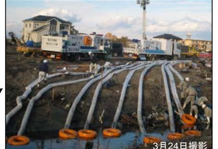
① ポンプ車(30m<sup>3</sup>/min級)稼動状況
