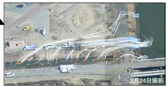
③ ポンプ車(60m<sup>3</sup>/min、40m<sup>3</sup>/min、30m<sup>3</sup>/min級)稼動状況
