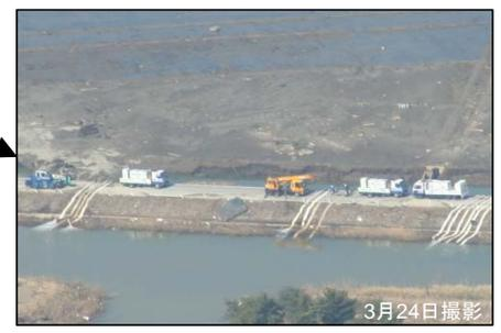
④ ポンプ車(30m<sup>3</sup>/min級)稼動状況
