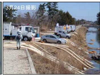
② ポンプ車(30m<sup>3</sup>/min級)稼動状況
