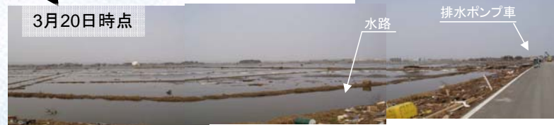
水位低下状況(水路水位で0.8m程度低下)
