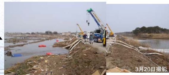
⑤ ポンプ車(30m 3 /min級)稼動状況
