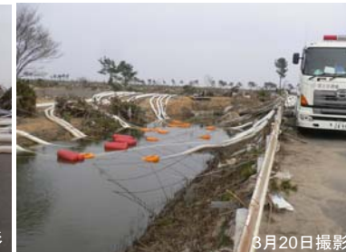
④ ポンプ車(60m 3 /min、40m 3 /min、30m 3 /min級)稼動状況
