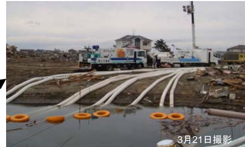
① ポンプ車(30m 3 /min級)稼動状況
