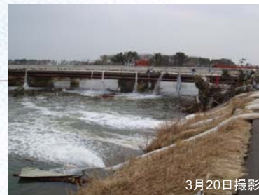
④ ポンプ車(60m 3 /min、40m 3 /min、30m 3 /min級)稼動状況
