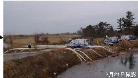
② ポンプ車(30m 3 /min級)稼動状況
