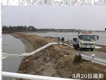
⑥ ポンプ車(30m 3 /min級)稼動状況
