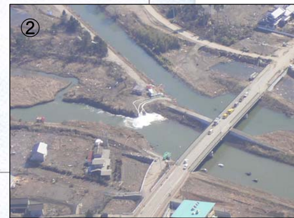
【仙台空港北側の排水状況】 ▲3月19日撮影
