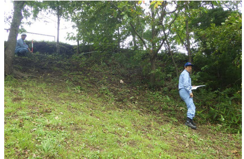
急傾斜地状況の調査
